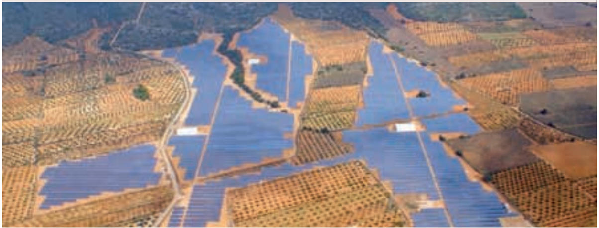
Das weltgrößte Silicium-basierte Photovoltaikkraftwerk mit einer Spitzenleistung von 20 MWp steht derzeit in Benexima, Spanien. Auf einer Fläche von mehr als 500 000 Quadratmetern (circa 71 Fußballfelder), erzeugen circa 100 000 Module den Strom für mehr als 12 000 Haushalte (etwa 3 Millionen Liter Diesel-Äquivalente/Jahr). Die derart erzeugte elektrische Leistung von mehr als 30 Millionen kWh/Jahr führen zu einer CO 2 -Einsparung von mehr als 30 000 Tonnen/Jahr.
